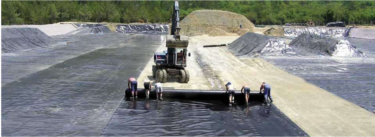
Slika 5. Prikaz procesa izgradnje deponije Možura
