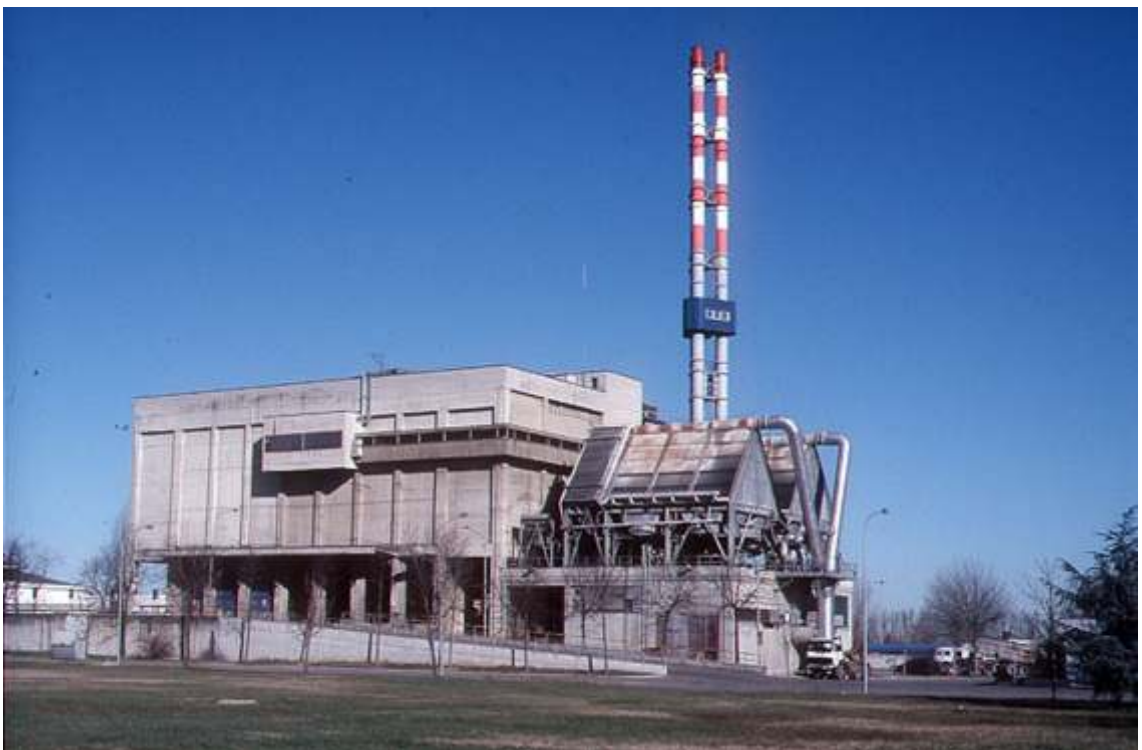
SPALIONICA OTPADA (INCINERATOR) U MODENI, ITALIJA
